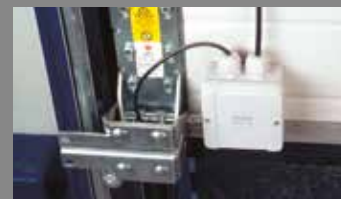
Seilbruchsicherung
